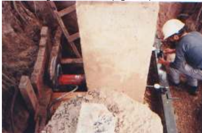
Figura 19 – Prova de carga horizontal usando o solo como reação
