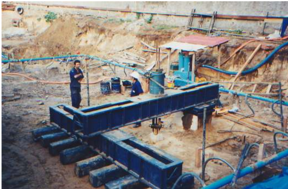
Figura 12 – Prova de carga à tração (reação em fogueira)
