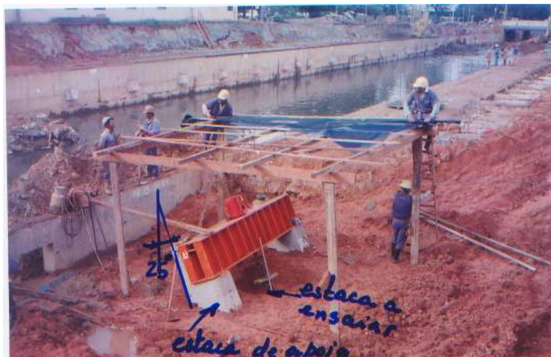
Figura 13 – Prova de carga à tração (reação em estacas)
